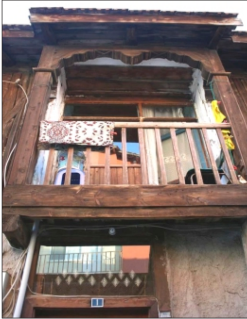
Resim-19 Güneşlik, Çavuşlar Mahallesi, Yusuf Aynagöz Evi
